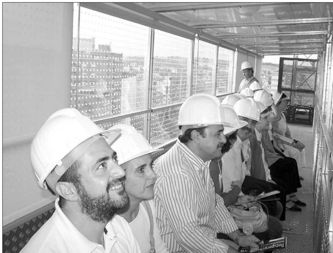
Visita a las obras de Restauración de la fachada de San Pablo
